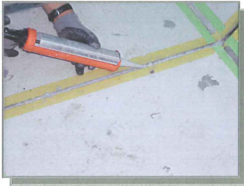
5. 弾性目地材注入
