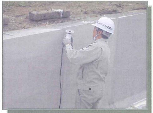
8. 天端高さ調整及び天端部目地材注入
