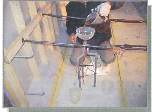
6. 接着剤注入(底板部)
