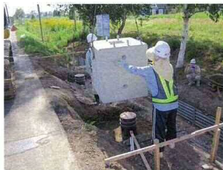
①鋼管杭に位置出して基礎ブロックを設置します。
