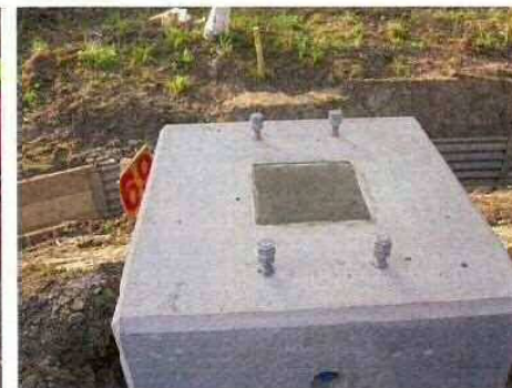
④完了。後は埋め戻すだけ！
