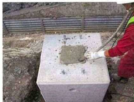
③コンクリートを打設します。
