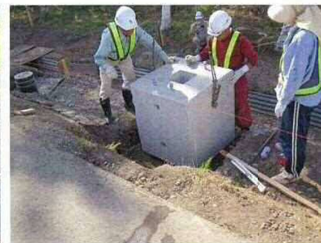
②基礎ブロック位置を微調整して
