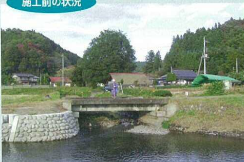
施工前の状況
