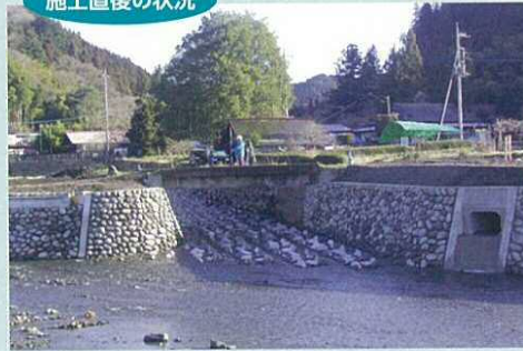
施工直後の状況
