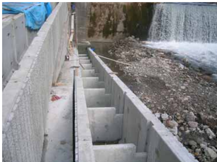
笹内川 全越流タイプ
