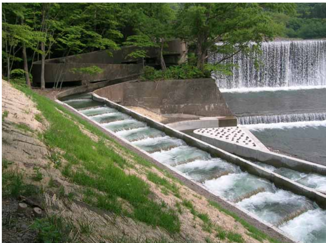
追良瀬川 全越流タイプ
