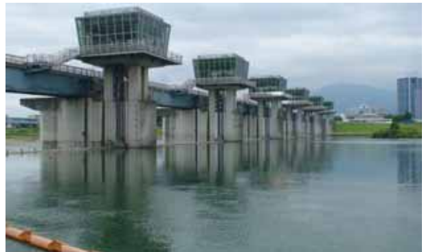
写真1 相模大堰の全景
