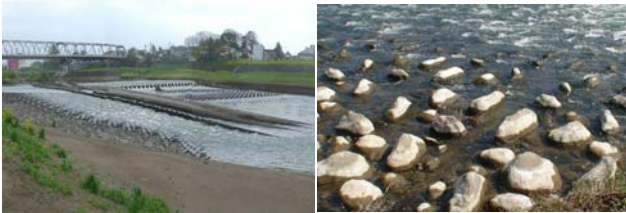
写真-3 粗石付護床エブロックの緩傾斜落差工への適用例
