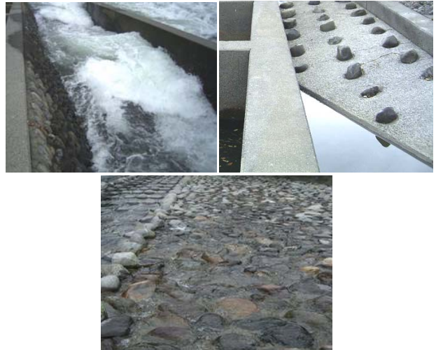
写真-1 粗石付魚道の施工事例
