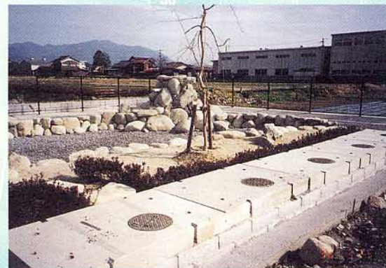
滋賀県 永源寺町
