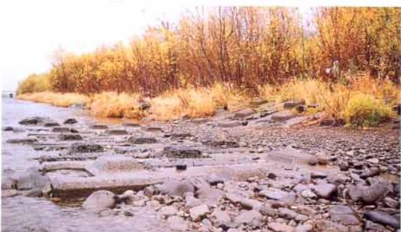
ポーラスコンクリート製根固めブロックを河川に設置し、水生昆虫の生息および藻類の付着状況を調査しています。付着藻類は、経時的に多様化しています。また、水生昆虫の生息も多く確認されています。冬期の凍結融解に対して、十分な耐久性があります。
