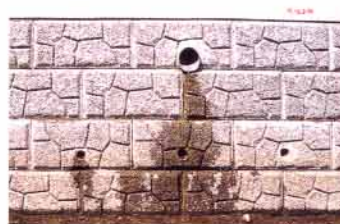
河床から2段目まで水位が上がり、ポーラスコンクリート部に土砂の堆積がみられ色が変わっています。
