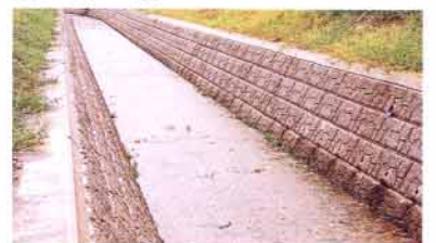
水際部に植物の生育がみられます。厚さが薄く、背面まで連続していないポーラスコンクリートでも水分の供給が十分あれば植生の繁茂に期待できます。
