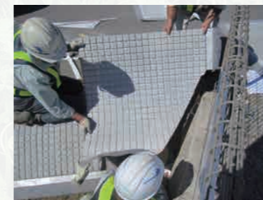
マルチマット設置
