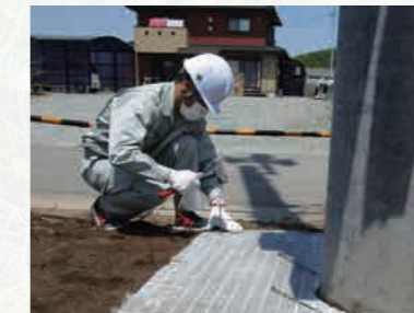
マルチセットピン打ち込み
