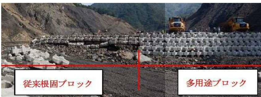
写真-2 床固工設置状況
