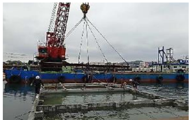
図-8 堤体工の据付状況
